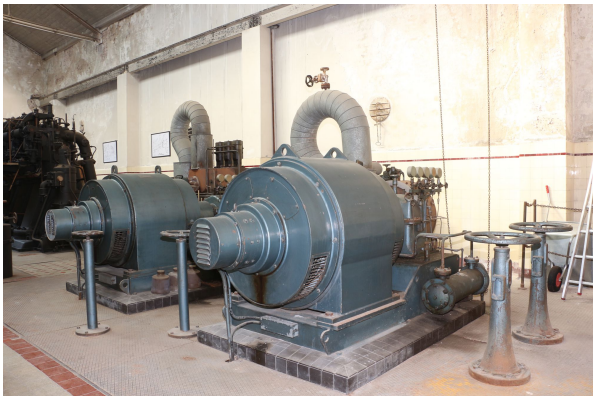
Abb. 52 Die Dampfturbinen im Wasserkraftwerk Dahlhausen
