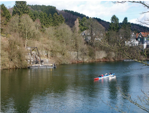
Abb. 56 Ob die Kanufahrer auf dem Stausee wissen, wofür der Stolleneinlauf ist ?
