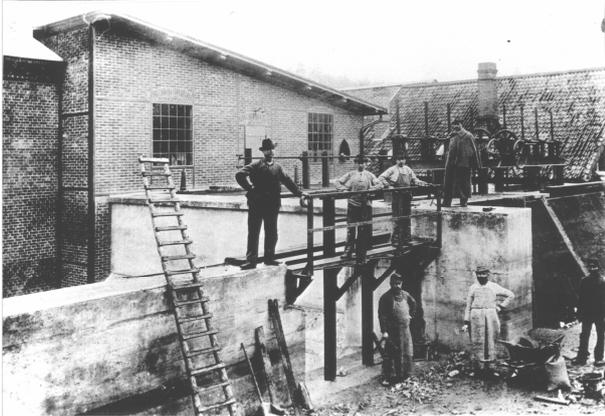
*Abb. 3: Vor dem Flutschütz des Wasserkraftwerkes Kräwinklerbrücke geflanschte Dynamos. (Erregermaschine)* Der Strom floß von dort über zwei Schleifringe durch die Magnetpole des Generatorläufers. Mit dieser Erregermaschine konnte man direkt auf die Ausgangsspannung des Drehstromgenerators Einfluß nehmen, die Frequenz des Drehstromes hing von der Tourenzahl des Maschinenblocks ab.
