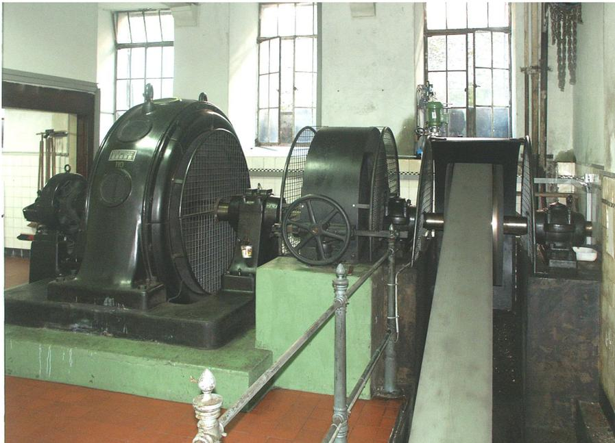
*Der 250 kW Generator in der Fa. Wülfing lieferte über 90 Jahre bis 2013 Strom ins öffentliche Netz. Weil er durchbrannte steht heute ein anderer Stromerzeuger an seiner Stelle*
