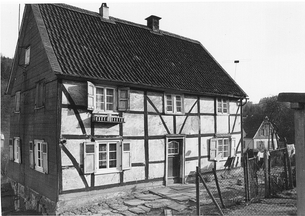
Abb. 21: Oege 88 Der Wupperverband bezeichnete dieses Haus „als minderwertiges Fachwerkhaus, welches abbruchreif sei. Die Toiletten befinden sich gegenüber auf der Wiese“ bemerkte der Verband weiter. Abbruch durch den Wupperverband im Februar 1970
