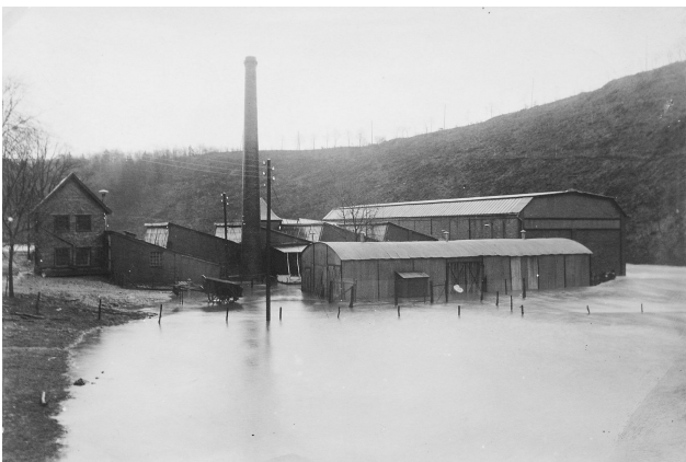
Abb. 6: Offenbar stand nicht nur die neue Halle im Flutprofil der Wupper
