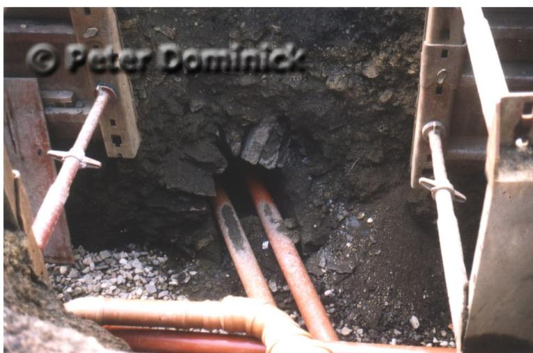
**Abb. 1** Schätze im Boden des Thüringsbergs: Die zwei modernen Rohre verschwinden in einem Bruchsteinkanal, durch den früher der Lennepebach vom Engelsteich in den Lüttringhauser Teich floß
