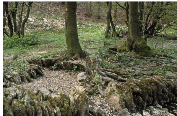
Abb. 9: Hochkant gestellte Bruchsteine gegen die Gewalten des Wassers.
