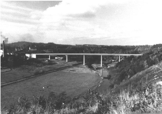
Abb. 9. In der zweiten Jahreshälfte 1967 war die neue Kräwinkler Brücke fertig.
