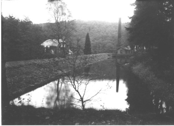
Abb. 17: Der Teich „F“ mit dem unteren Pumpwerk um 1900. Im Hintergrund ist der Schornstein der Fahrradfabrik „Elite“ zu erkennen.
