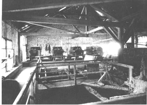
Abb. 5 Um 1900 trennten diese Filterpressen die festen Stoffe aus dem Abwasser. Übrig blieben „Filterkuchen“
