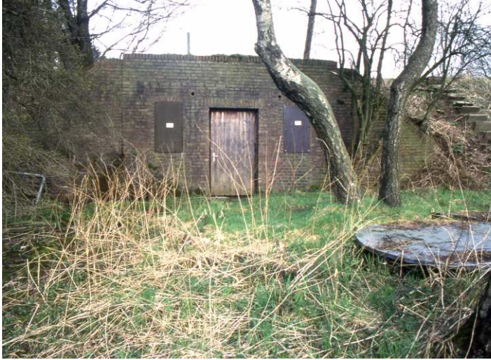
Abb. 25: Das Pumpwerk im Damm des unteren Rotzkotter Sees ist im Jahr 1999 längst außer Betrieb
