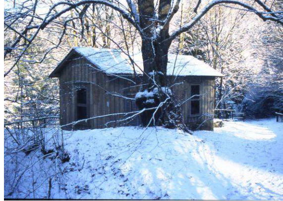
Abb. 18 Winterstimmung am Pumpwerk in Diepmannsbach im Januar 1999. An den Aggregaten im Innern nagt der Zahn der Zeit
