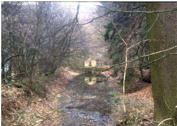
Abb. 19 Der ausgetrocknete Teich vor dem Pumpwerk diente vor über 120 Jahren als Obergraben für die Fabrikurbine
