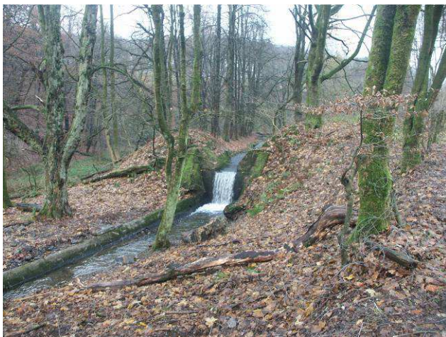
Abb. 21: Der zum „Grundbach für Abwasser“ degradierte Diepmannsbach in Höhe der ehemaligen Buchholzmühle
