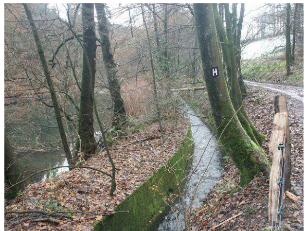
Abb. 22: An Teich „E“ fließt der Abwassersammler vorbei durch enge Rinnen
