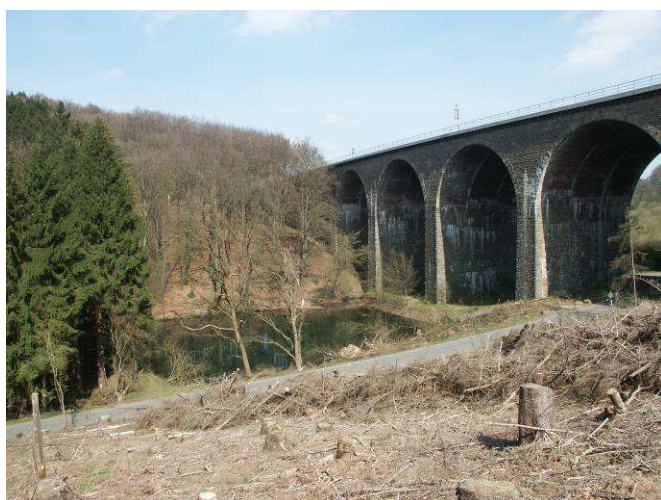
Abb. 20: Der Endringhauser Teich „G“ vor der Autobahnbrücke in Diepmannsbach ist durch eine Rohrleitung mit Teich „F“ verbunden
