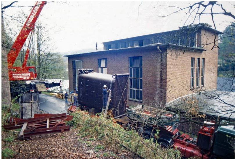
Abbau des gasbefeuerten Dampfkessels im April 1999.
